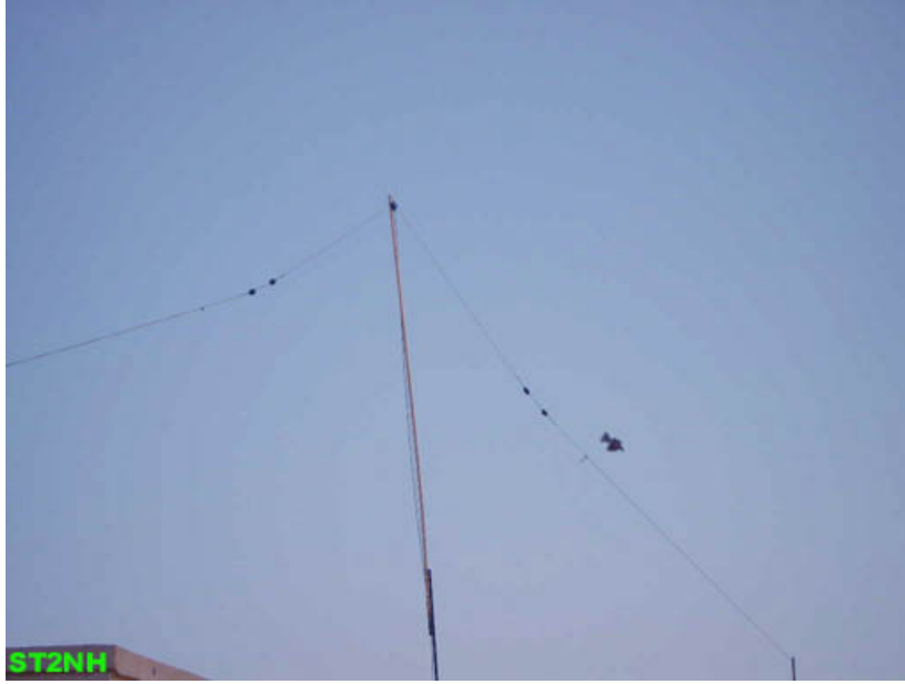
الدايپول منصوب بطريقة الانسدال لاحظ الطائر يعشق الهوائيات
